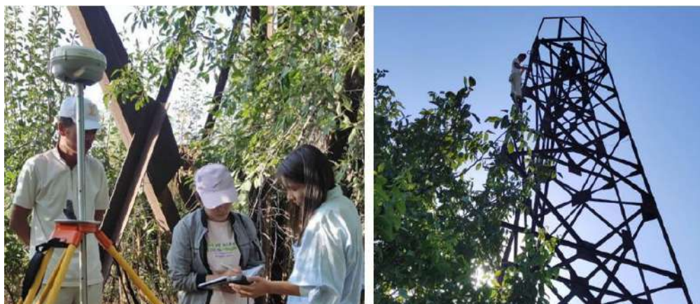
Рисунок - 2. ГНСС измерения на пункте “Болта”
